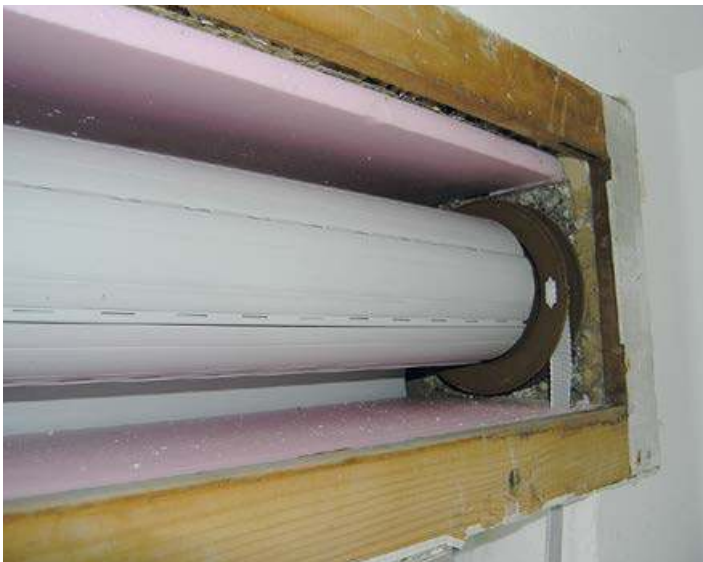
Nachträgliche Dämmung eines Rollokastens
