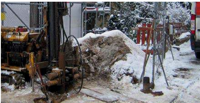
Vor Bohrungen in die Tiefe muss die Eignung des Bodens geprüft werden.
