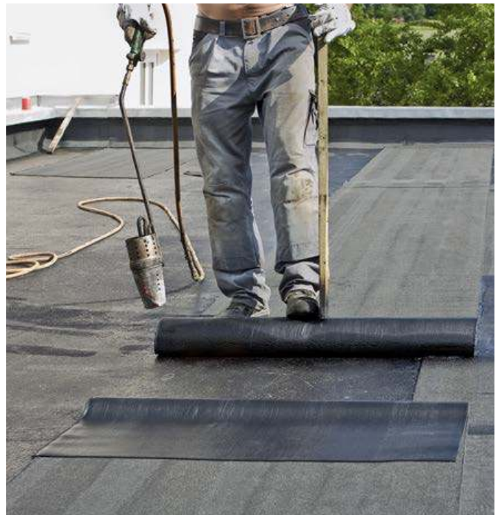
Abdichtungsarbeiten auf einem Flachdach
