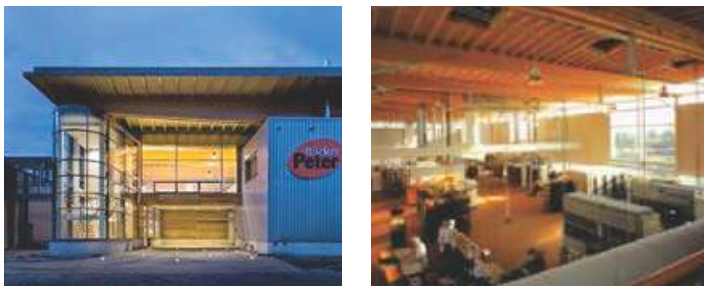
Gebäudestruktur: weitgespannter Holzbau, Holzfassaden
