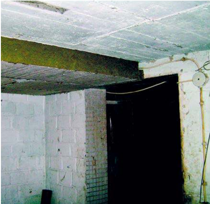
Dämmung der Kellerdecke von unten
