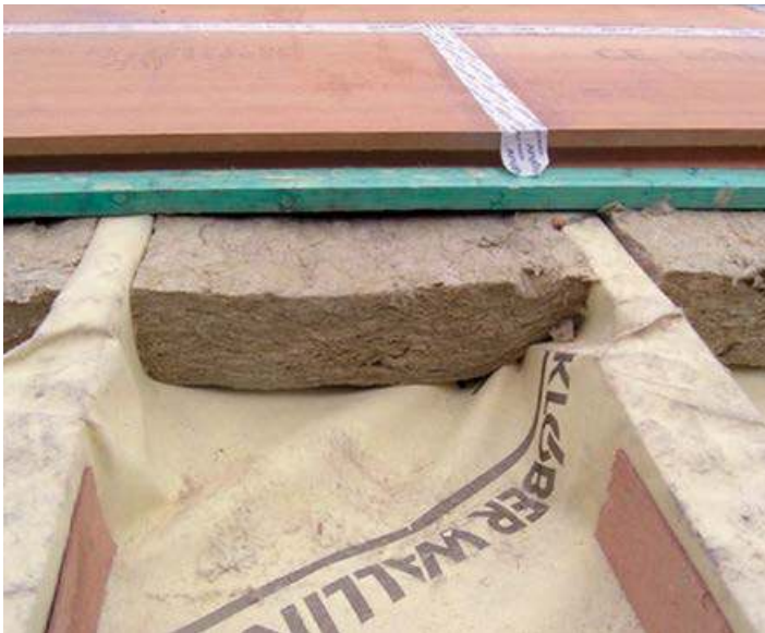
Modernisierung von außen: Dämmung zwischen und auf den Sparren
