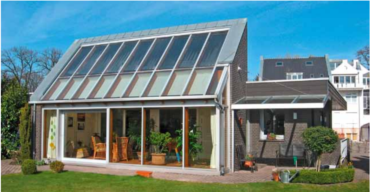
Heizen mit der Sonne kann vielfältig sein; hier mittels Solarkollektoren und nicht beheizten Wintergarten.
