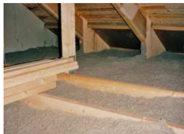
Abb. 39 Einbau einer Schüttung als Zwischendeckendämmung
