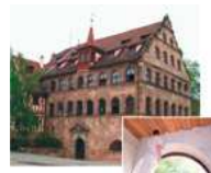
Abb. 45 Innendämmung der Fassade eines denkmalgeschützten Gebäudes
