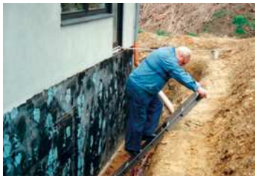
Abb. 35 Nachträgliches Einbringen einer Perimeterdämmung
