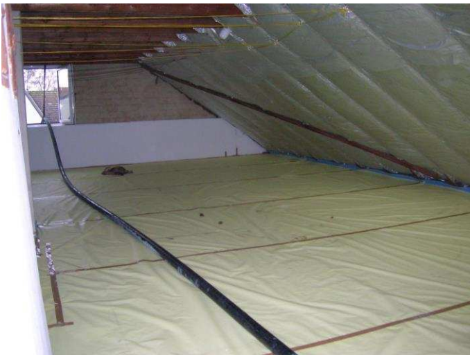
Dämmung der obersten Geschossdecke und des Daches
